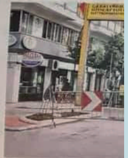
I lavori per dividere in due una rotatoria
