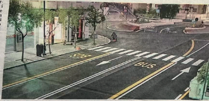
Viale Marconi trasformato a quattro corsie dopo i lavori avviati dal Comune
